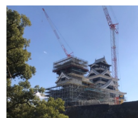
※修復中の熊本城
